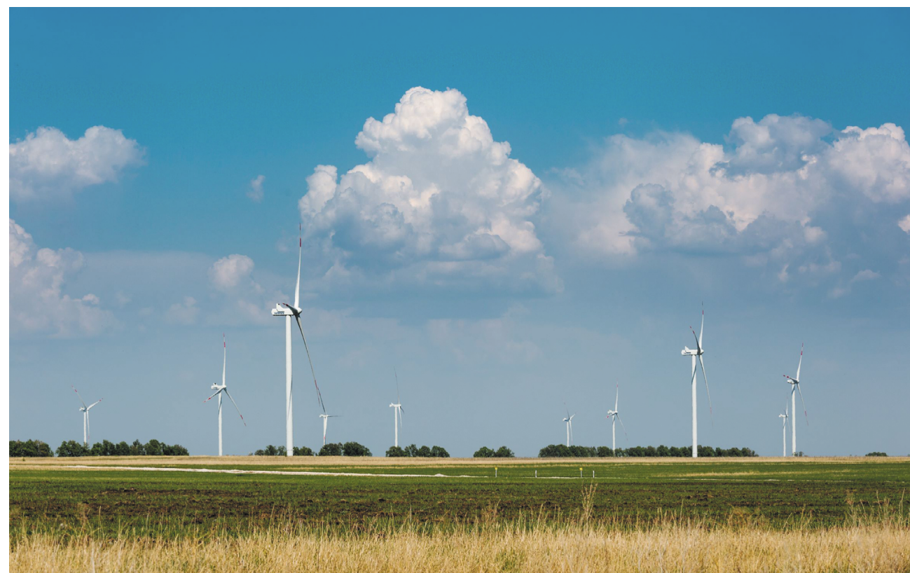
1-й Ветропарк ФРВ - Ульяновская ВЭС. © «УК «Ветроэнергетика»
