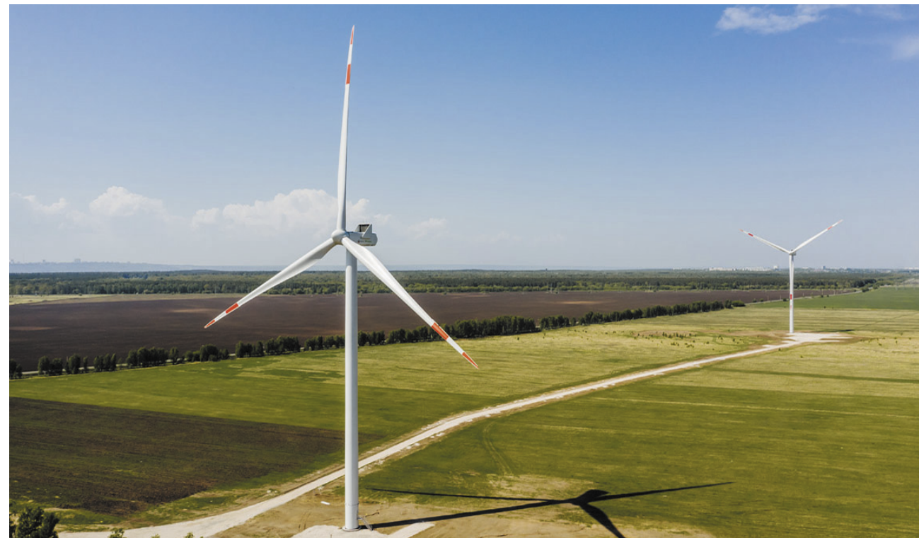
1-й Ветропарк ФРВ - Ульяновская ВЭС. © «УК «Ветроэнергетика»
