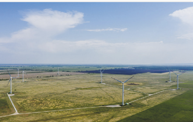
1-й Ветропарк ФРВ - Ульяновская ВЭС. © «УК «Ветроэнергетика»
